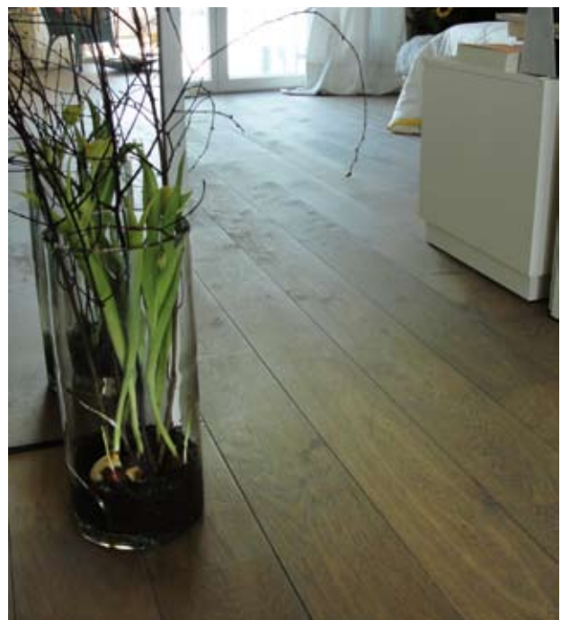
Die Durchgänge wurden nahtlos verlegt.
